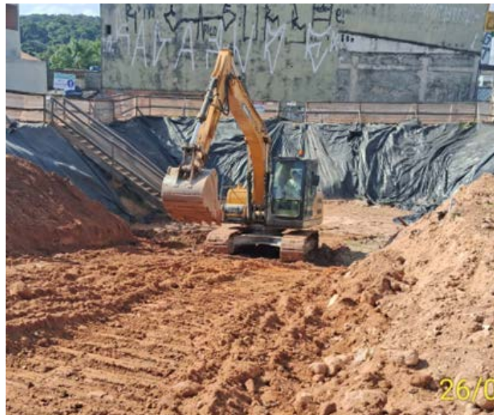
Acesso Norte – Preparação para execução das fundações
