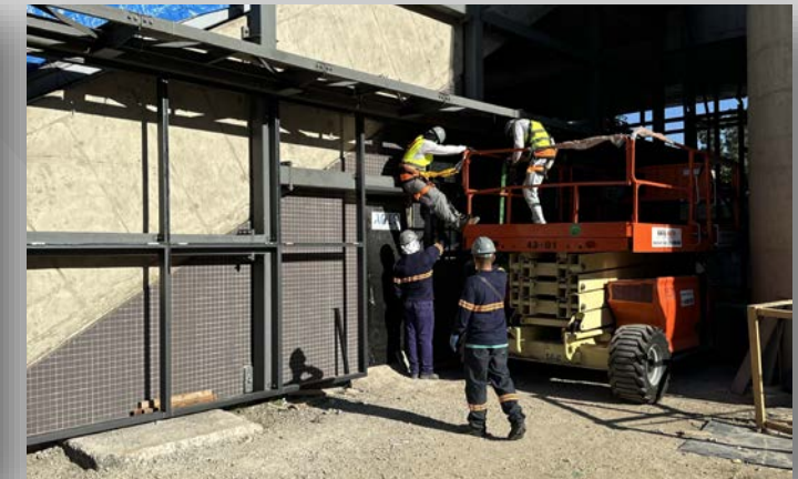
Preparação para a instalação dos vidros das escadas do Acesso A
