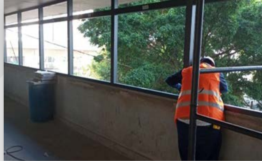
Instalação de esquadrias na Sala de Equipamentos Eletrônicos
