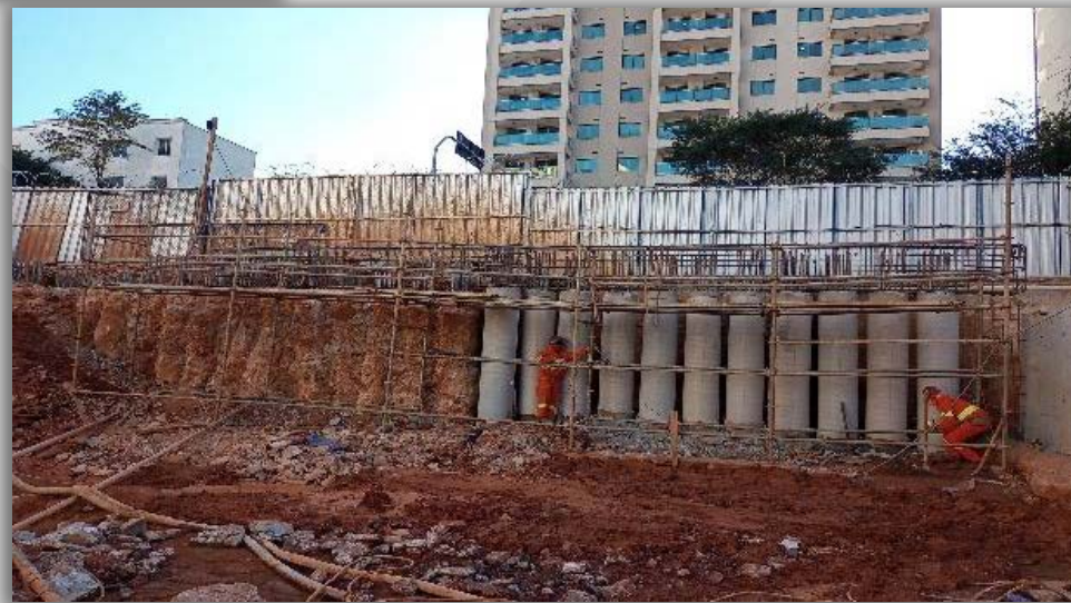
Execução das estacas de contenção
