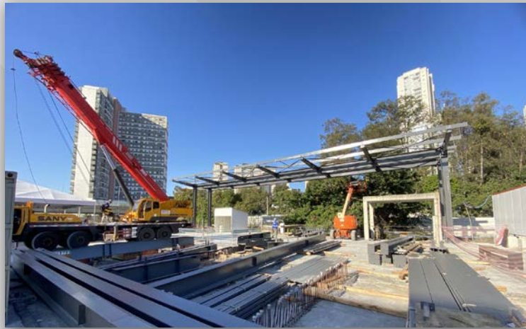
Bloco G - Execução da Estrutura Metálica da Cobertura
