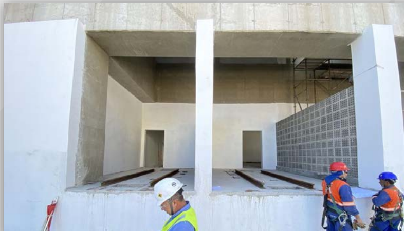
Bloco D - Instalação dos trilhos na Sala de Trafos
