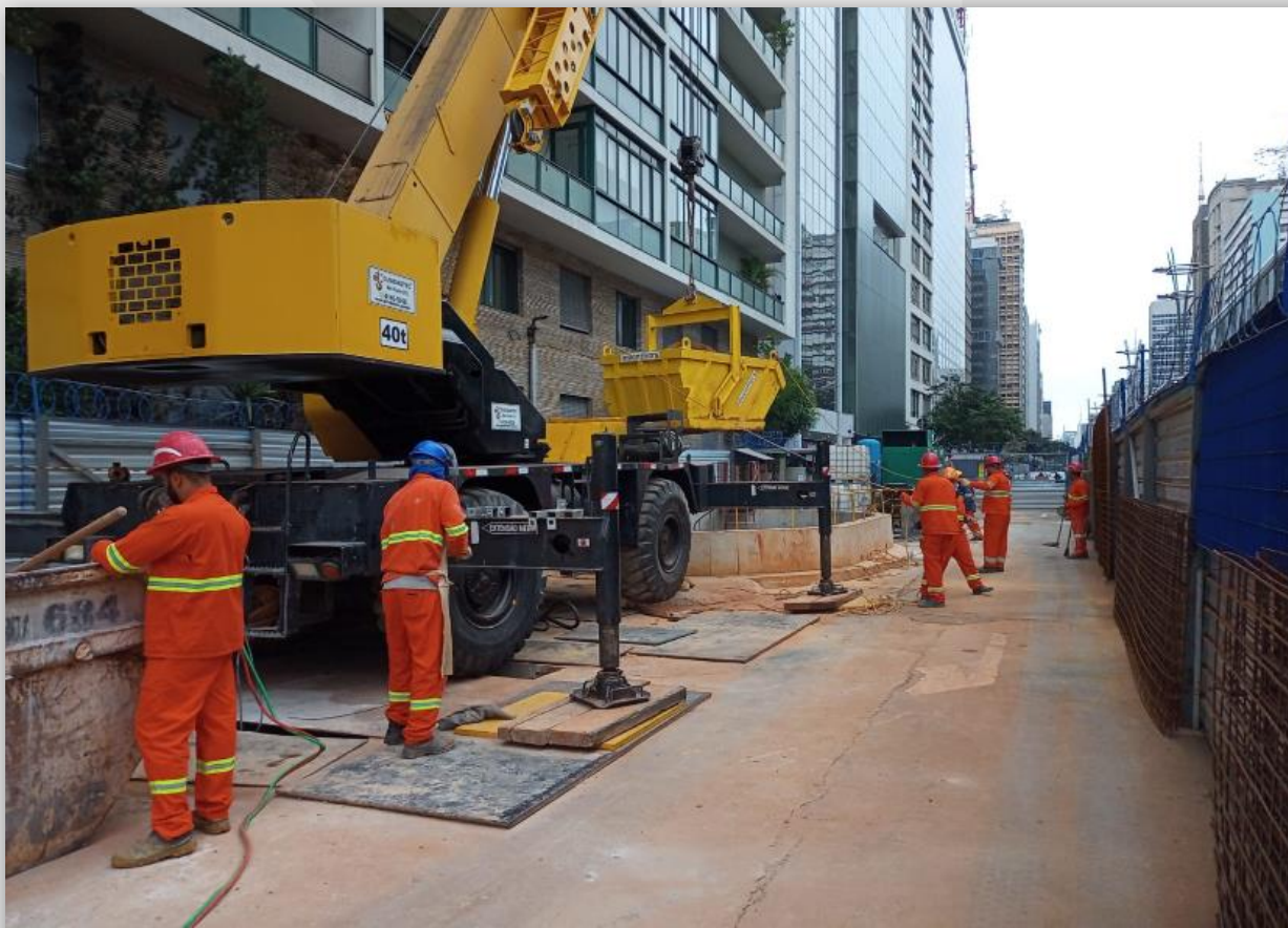
Vista geral do canteiro na Av. Paulista
