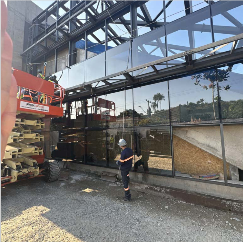
Instalação dos vidros das escadas do Acesso B
