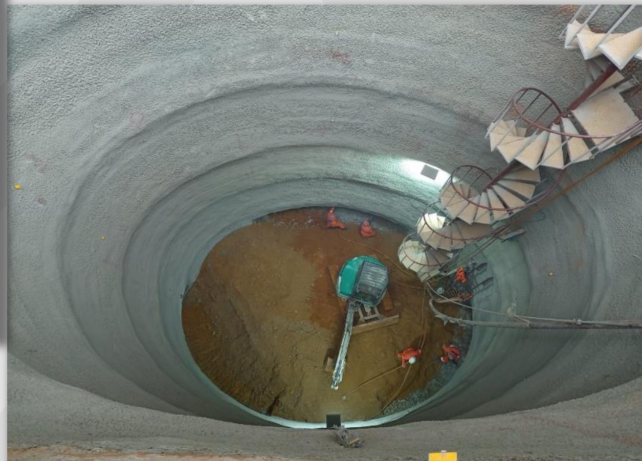
Poço de Ataque – Escavação do 17º Avanço (de 31)
