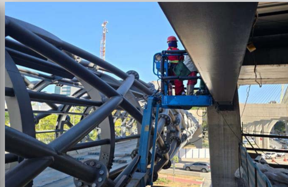
Ajustes da Estrutura Metálica do Acesso da Estação
