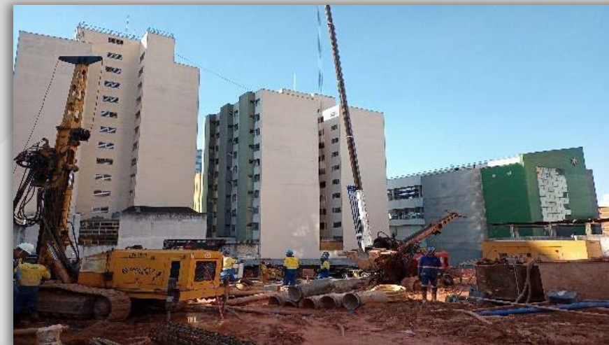
Execução de poços de rebaixamento
