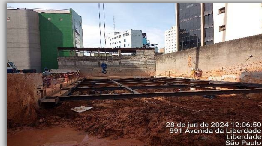
Execução de escavação e estroncamento
