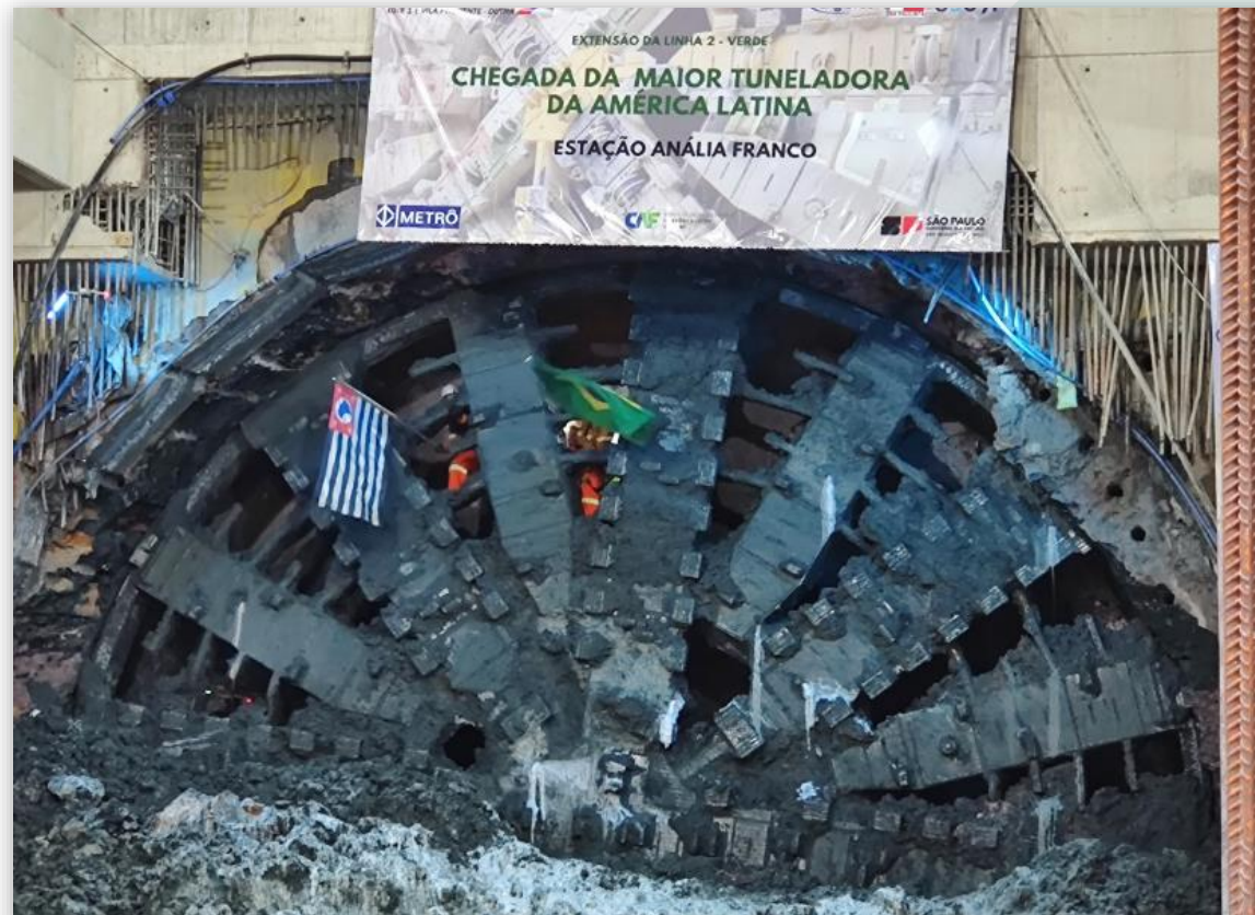
Chegada da TBM na Estação Anália Franco
