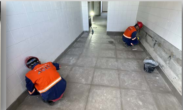
Execução de rejunte no piso de porcelanato no Edifício Técnico Operacional
