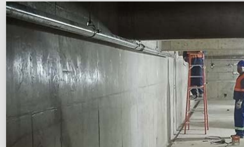
Execução de redes hidráulicas no Porão de Cabos
