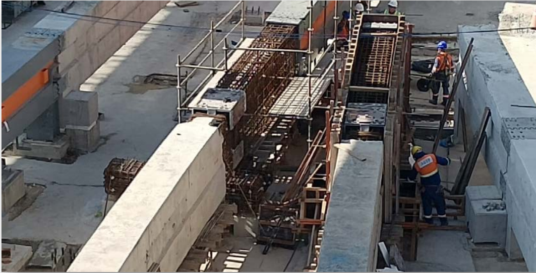
Solidarização de vigas-guias
