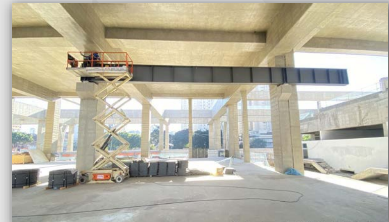
Bloco E - Instalação de trilhos para Ponte Rolante
