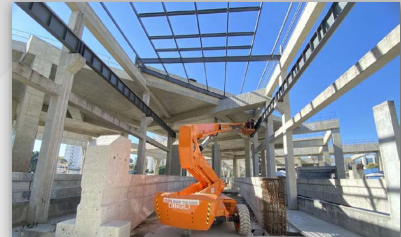
Bloco C - Execução da Estrutura Metálica da Cobertura
