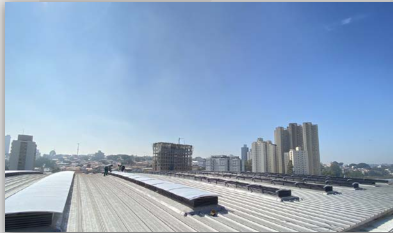
Bloco A - Execução de Domus na cobertura
