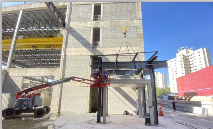
Bloco G1 - Execução da Estrutura Metálica da Cobertura
