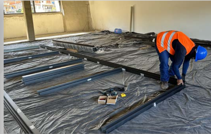
Instalação de caixilhos na Sala de Equipamentos Eletrônicos (SEE)
