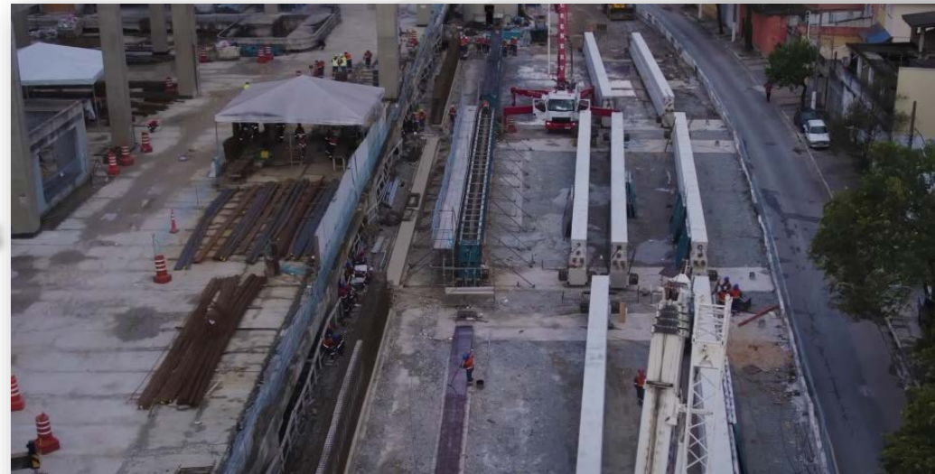
Fabricação de vigas-guias
