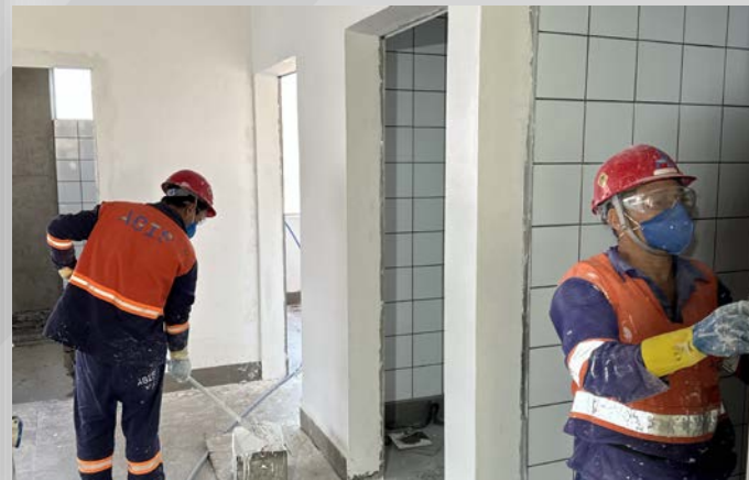
Execução de pintura no Edifício Técnico Operacional
