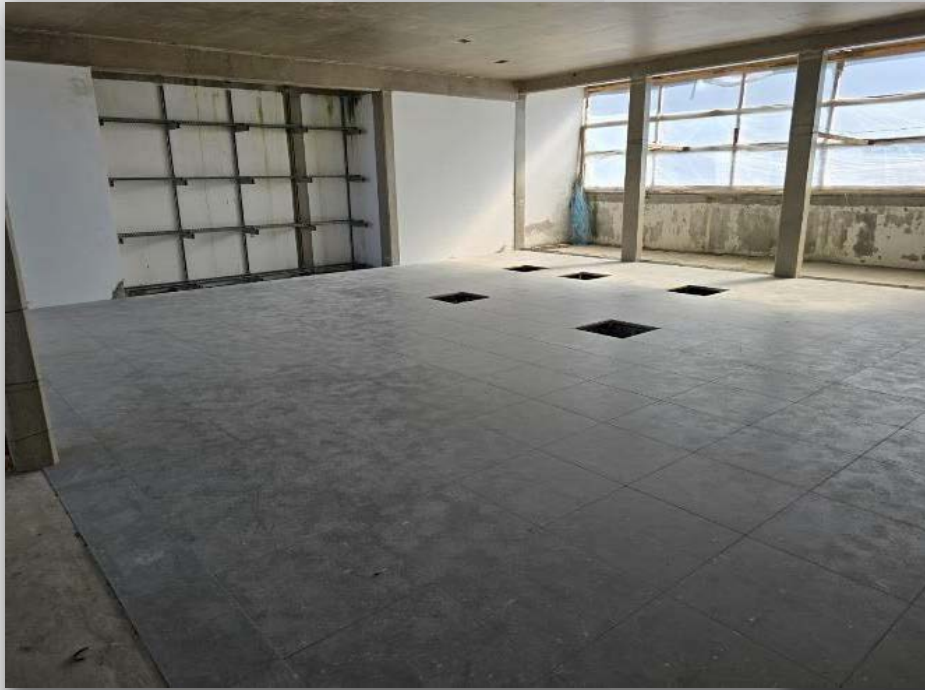
Execução do piso elevado da Sala de Equipamentos Eletrônicos (SEE)
