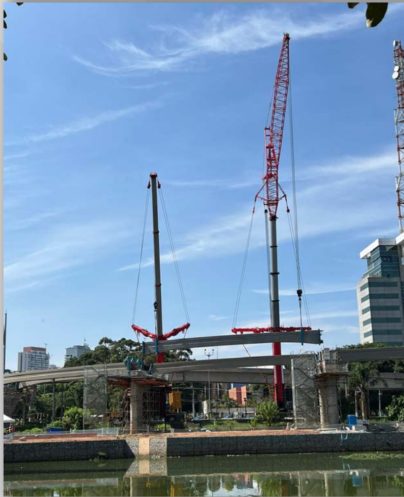
Lançamento de viga-guia na Marg. Pinheiros
