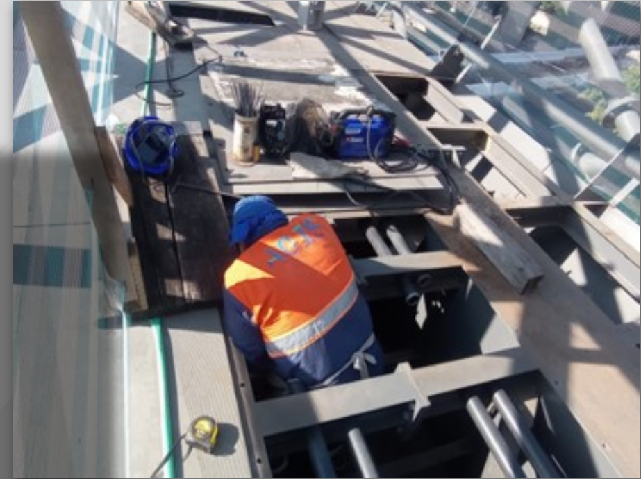
Instalação de eletrodutos na passarela do Acesso B
