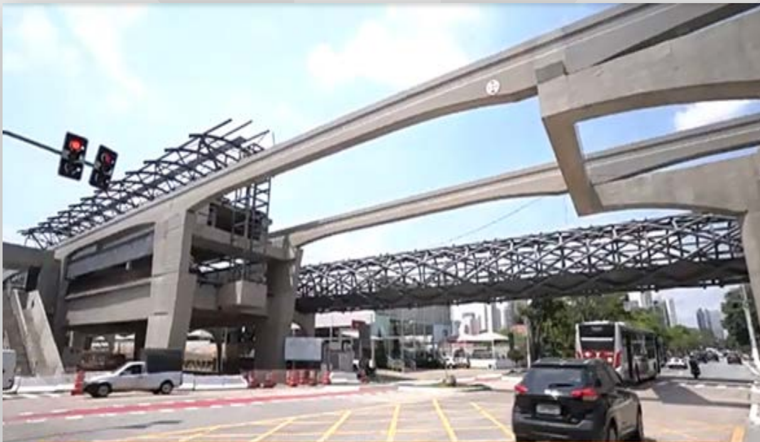
Cobertura Metálica do Corpo da Estação
